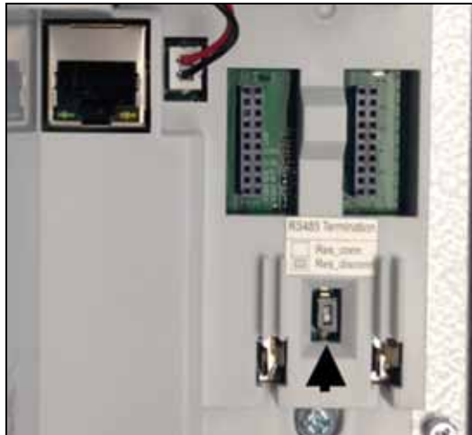
Figura 8. Resistenza di terminazione e schermatura
